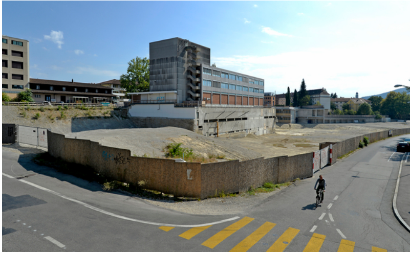
Hier wurde früher der Berner Kehrriech verbrannt. Demnächst sollen am Warmbächliweg 250 Wohnungen entstehen. Bild: Stefan Anderegg
